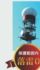
スペイン気象庁の気象レーダーに設置。バスク地方は雷の発生率が高い地域として知られています。dinnteco-100plus設置直前にはレーダーへの直撃雷があり、実証実験期間中も2km圏内で96回の落雷がありましたが、保護範囲内への落雷は、冬季雷含め0件となりました。
